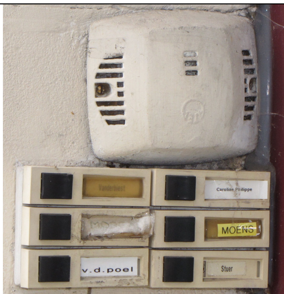
Wilrijk, Spoorweglaan 169 Bemerck de omgekeerde montering, en de vele verflagen. De bonte verzameling van namen en de manier waarop ze zijn ingegeven, doen huurappartementen vermoeden.
