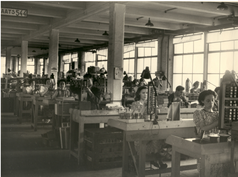
Figuur 8: montage van halffabricaten ( relaygroepen)
