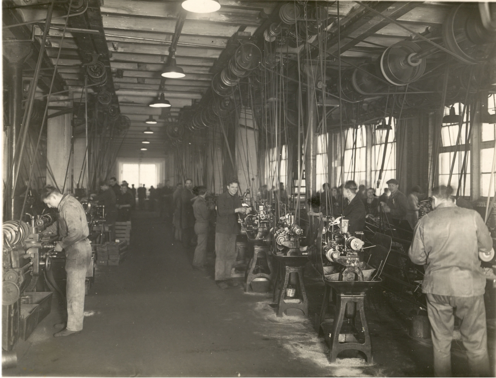
Figuur 5: DRAAIERIJ: draaibanken aangedreven via een bovenhangende as met één gemeenschappelijke motor.
