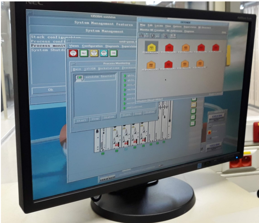
Figuur 5: Monitor van het management systeem in Oostende
