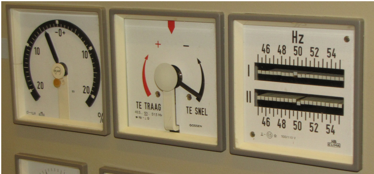
Figuur 9: Synchro metingen in 2015 met volt-, phase- en frequentiemeter, net als bij de synchrokolom in de jaren 1920, maar in andere uitvoering
