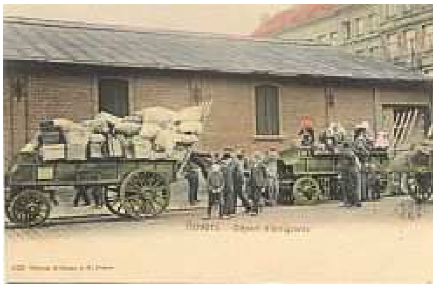
Aankomst van emigranten met bagage aan de gebouwen van de Red Star Line in Antwerpen.
