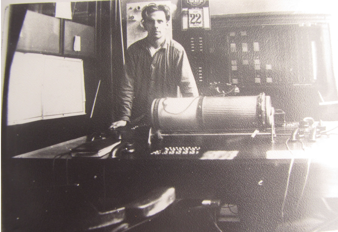
Figuur 2: Installatie bij de bank Kassel en Naegelmaeckers (22 juni 1926)
