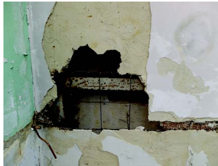
afb. 24a: dezelfde noordelijke helft met zicht op de scheidwand van de 2 middelste traveeën – afb. 24b: plafond, dat niet langer opgehangen is aan de Polonceau-spanten maar aan een raster van I-balken, die in het midden ondersteund worden door verticale 'ingepakte' I-balken (2015)
