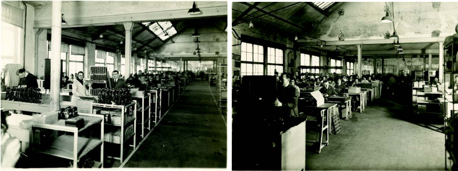
afb. 22de: vermoedelijk de zuidelijke helft in een latere fase (elektrische verlichting) met zicht op de scheimuur van de middelste traveeën, die nu is doorbroken en gestut door verticale 'geklonken' I-balken - op de voorgrond links zogenaamde 'candlestick' telefoons op de tafels tussen de kolommen van de 2 uiterst rechtse traveeën (22d - ca 1920?) en tegelvloer (22 e - 1927-29?). 18
