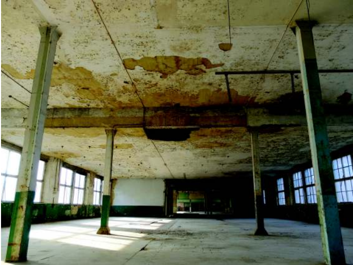
afb. 25: in de zuidelijke helft is het plafond (in betonraster) nog steeds opgehangen aan de oude Polonceau-spanten
