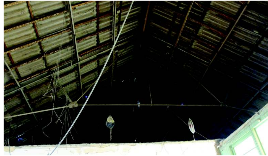
afb. 25: in de zuidelijke helft is het plafond (in betonraster) nog steeds opgehangen aan de oude Polonceau-spanten
